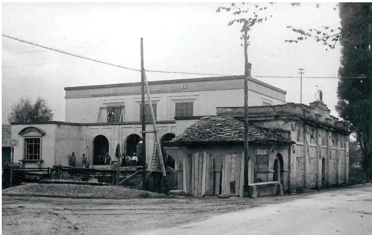
Veduta dell'edificio all'epoca della costruzione nel 1929 sul sedime del della struttura che ospitava "le Jeu de l'Archibuse".
