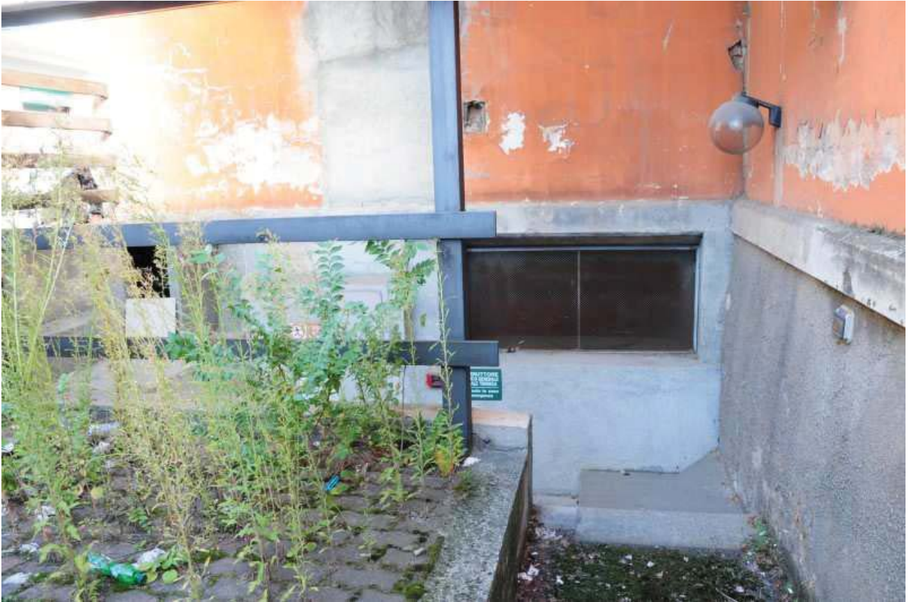
Vista ingresso al piano interrato.
