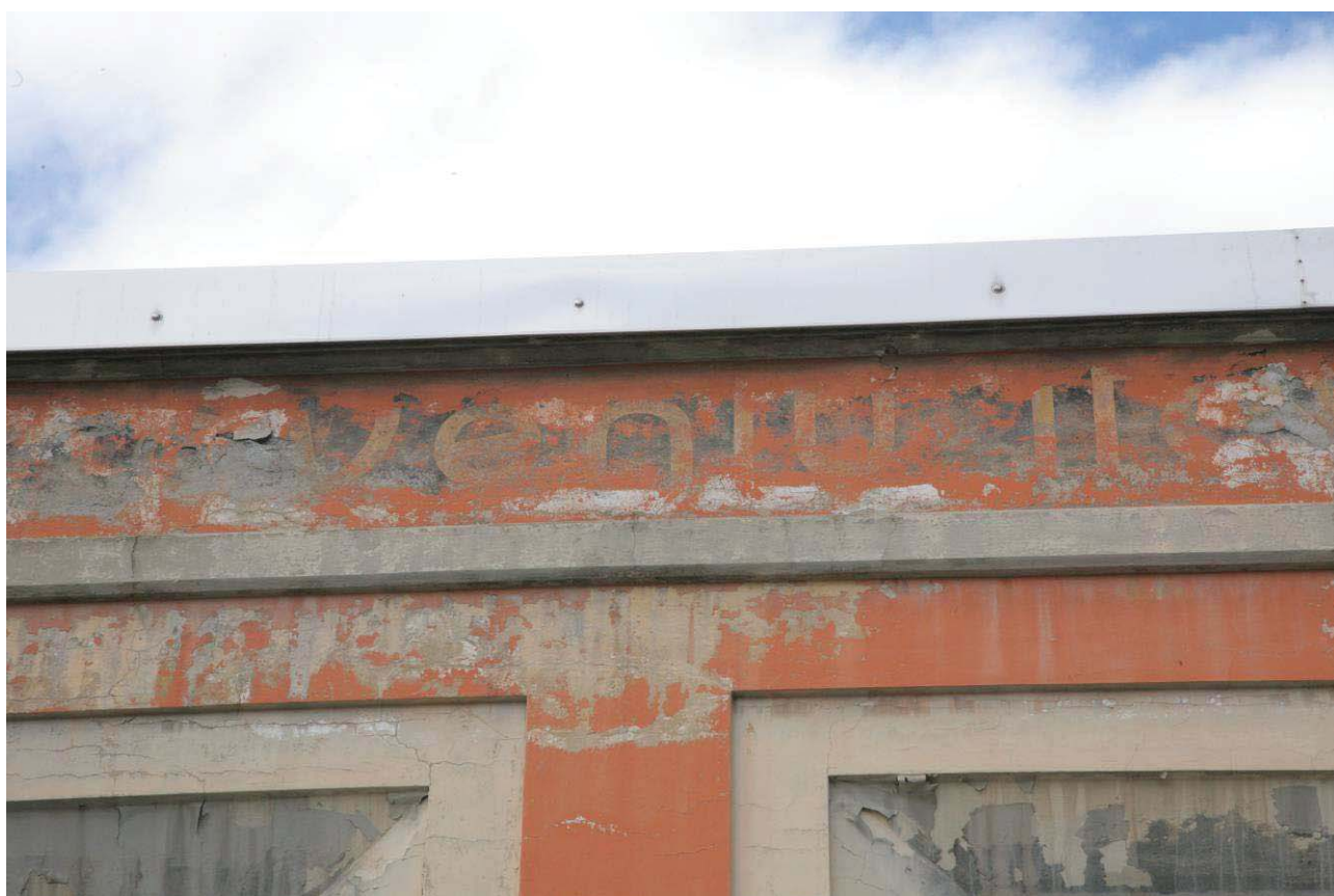
Particolare dell'iscrizione presente sopra l'entrata principale.
