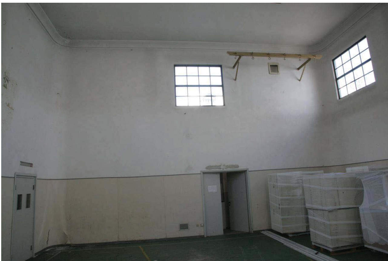
Vista interna lato corto della palestra.
