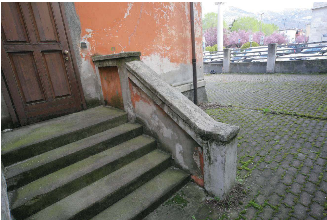
Vista della scalinata di accesso laterale presente sul lato Sud.
