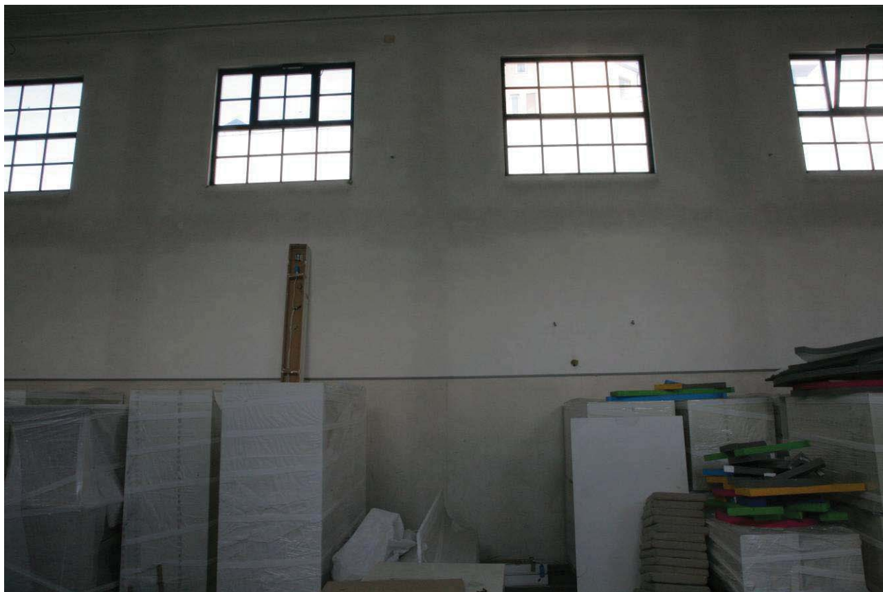
Vista interna del lato lungo della palestra – si noti il disegno della struttura portante sulla parete.
