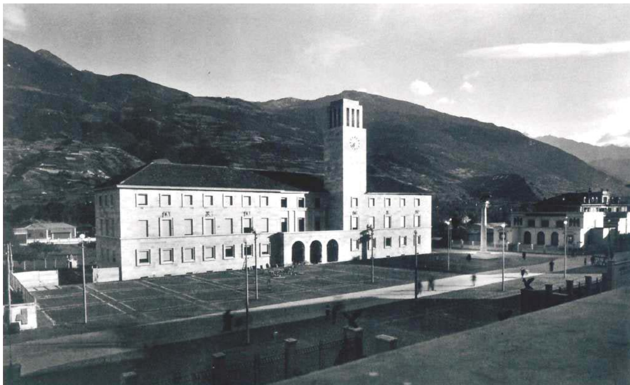
Veduta di Piazza della Repubblica dopo il 1939. Sul lato destro si noti la Salle de Gymnastique con le tre arcate di ingresso riproposte nell'adiacente "casa Littoria".
