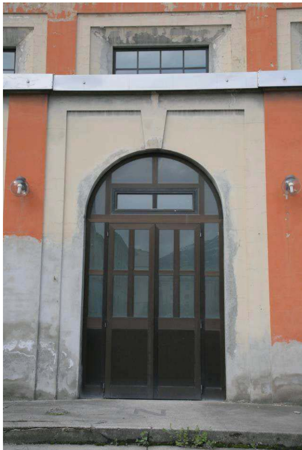
Particolare facciata principale.
