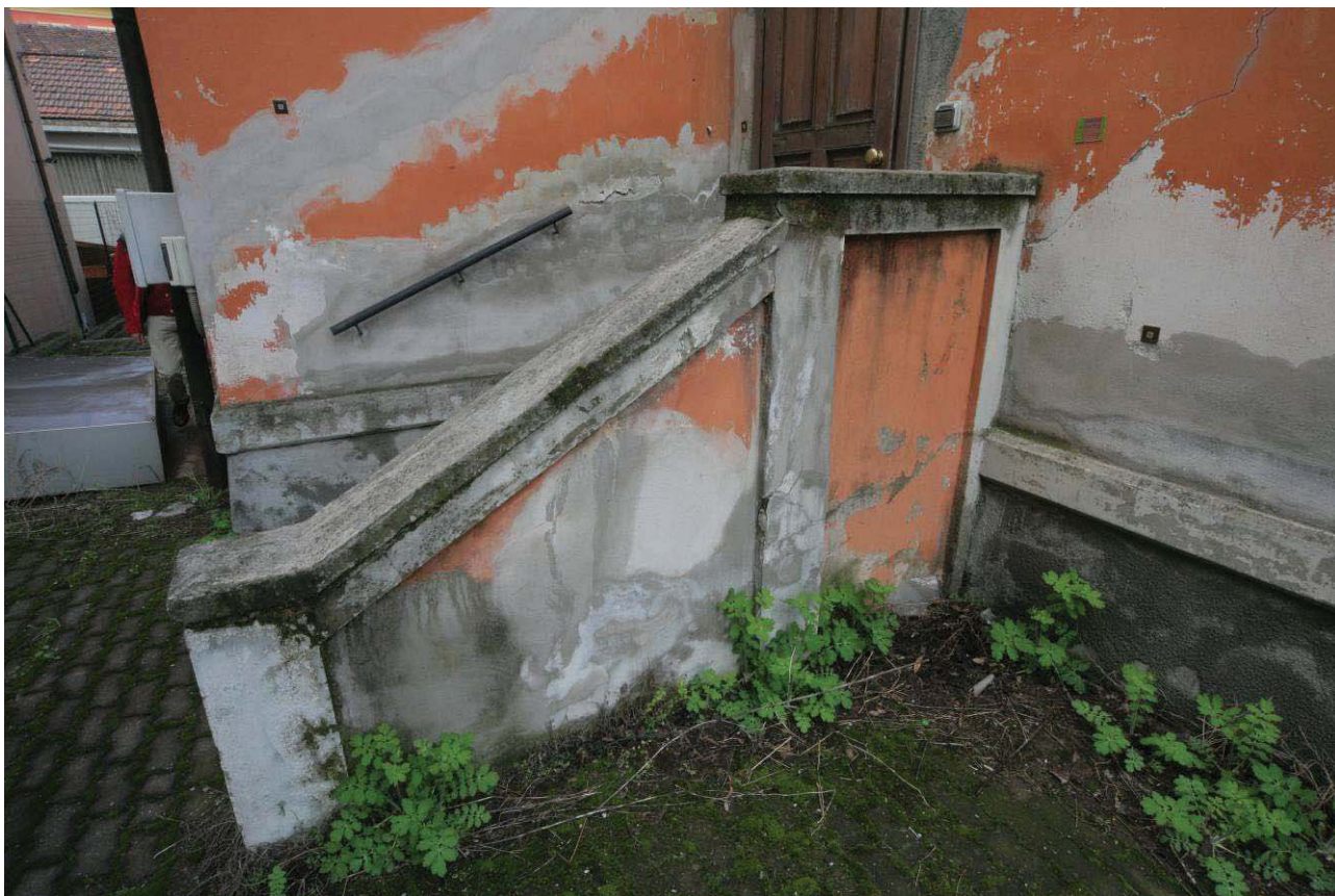
Particolare della scala di accesso posta sul lato Sud.
