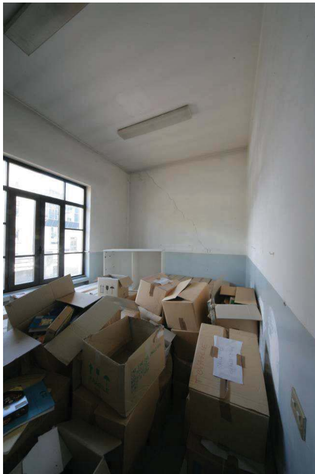
Vista interna di uno dei locali deposito.
