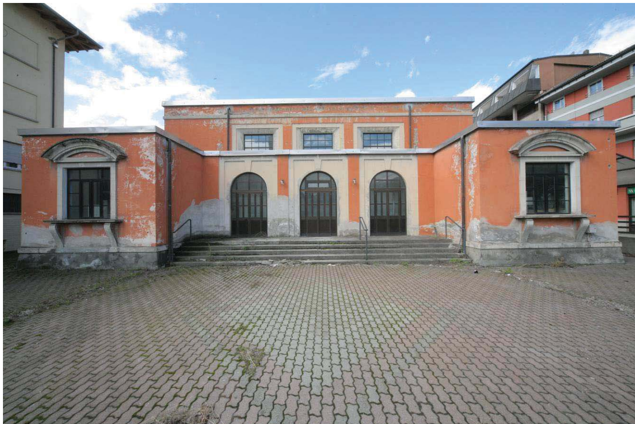
Vista lato Est – prospetto principale.
