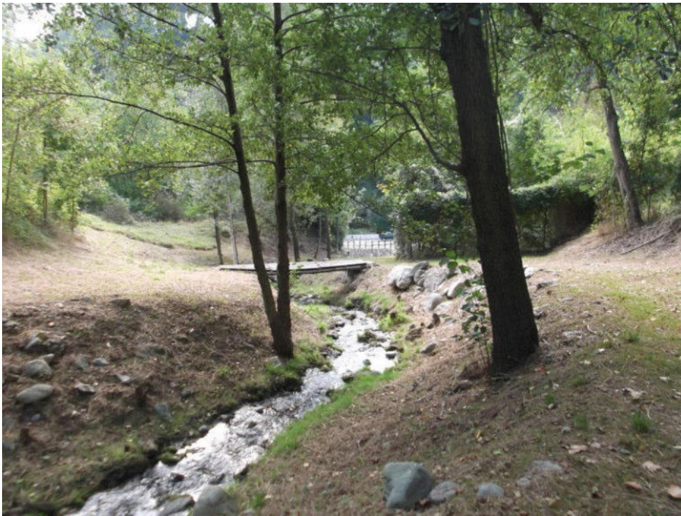
FOTO 14: tratto poco a valle del precedente: si nota sulla sinistra la sponda rilevata per la presenza dell'antico terrazzamento e verso valle il tratto terminale arginato.
