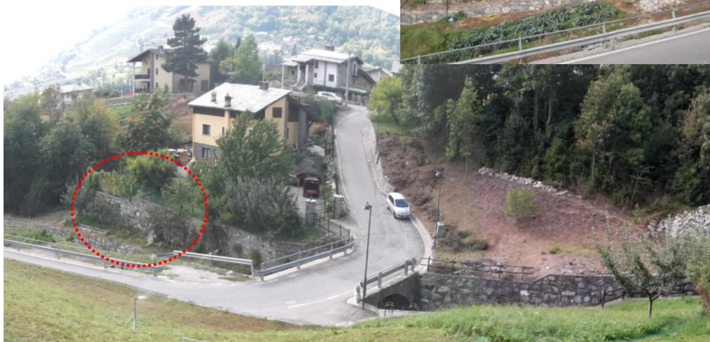
FOTO 34-35-35bis: panoramica del settore inferiore dell'abitato di Truchod, interessato dal dissesto della sponda destra del torrente Parléaz nel corso dell'alluvione del 2000 (foto sopra fornita dal Comune di Aosta). Circolettato il settore interessato dalla forte erosione spondale con asportazione di argine e muro di sostegno del giardino della soprastante abitazione ben visibile nella foto del 2000.
