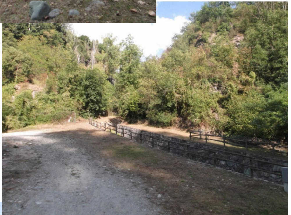
FOTO 15: tratto terminale arginato. Si noti sulla sinistra (ds. guardando) la scarpata rocciosa dell'antico terrazzo.
