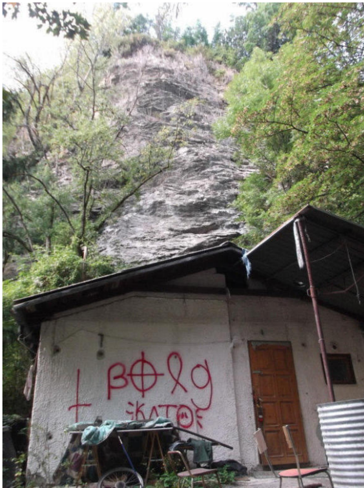
FOTO 20: parete rocciosa ricoperta da rete a doppia torsione a protezione del fabbricato presente in apice di conoide.
