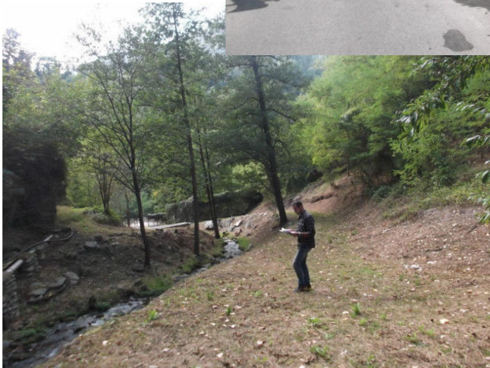
FOTO 13: panoramica del settore apicale del conoide del T. Parléaz, che scorre in una alveo naturale poco inciso. Poco a valle, presso il ponte visibile in secondo piano, è stata identificata la sezione oggetto di verifica idraulica.
