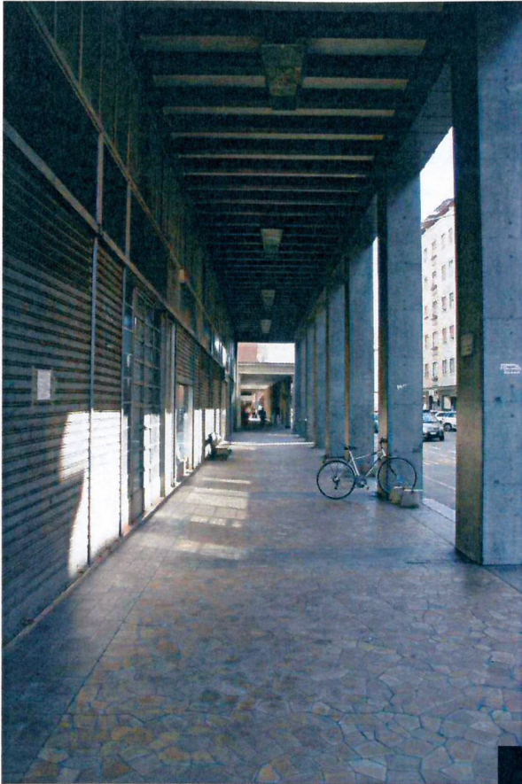
Vista del porticato su c.so Battaglione Aosta.
