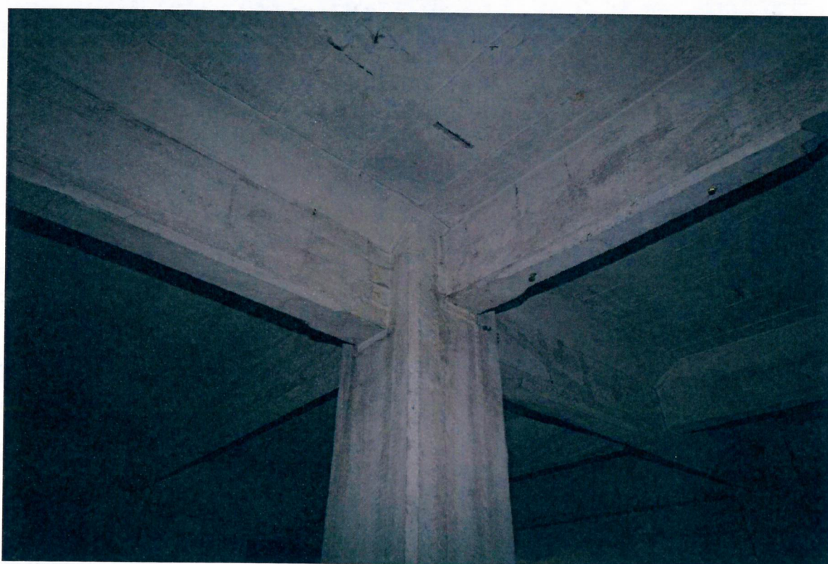
Particolare del giunto travi-pilastro del primo piano interrato.
