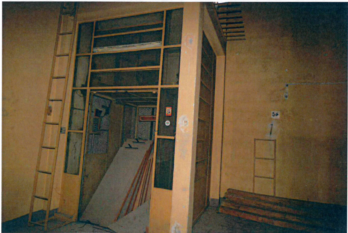
Vista del montacarichi del deposito dell'attività commerciale centrale "ex Canonico".
