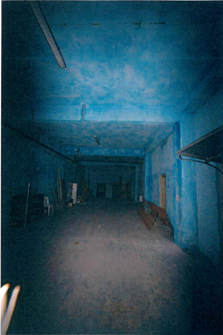
Vista dei locali di deposito posti al primo piano interrato lato via G. Elter.
