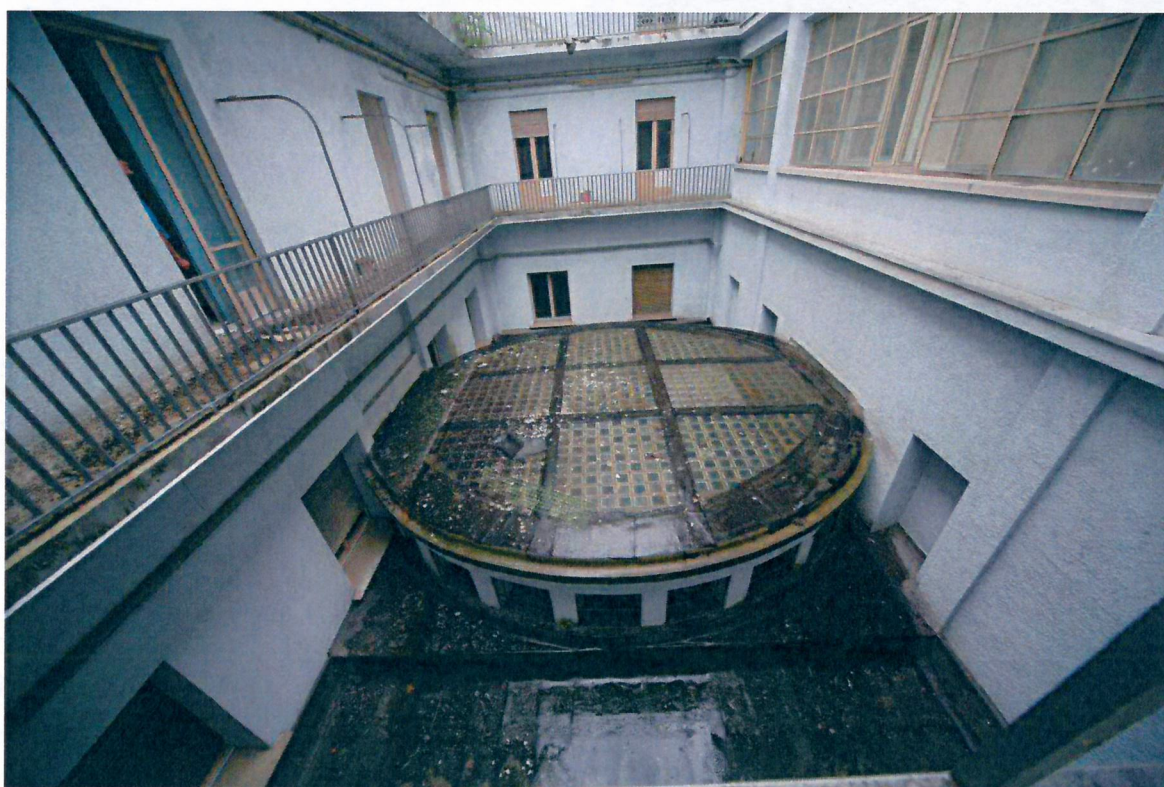
Vista cavedio e lucernario dal secondo piano.
