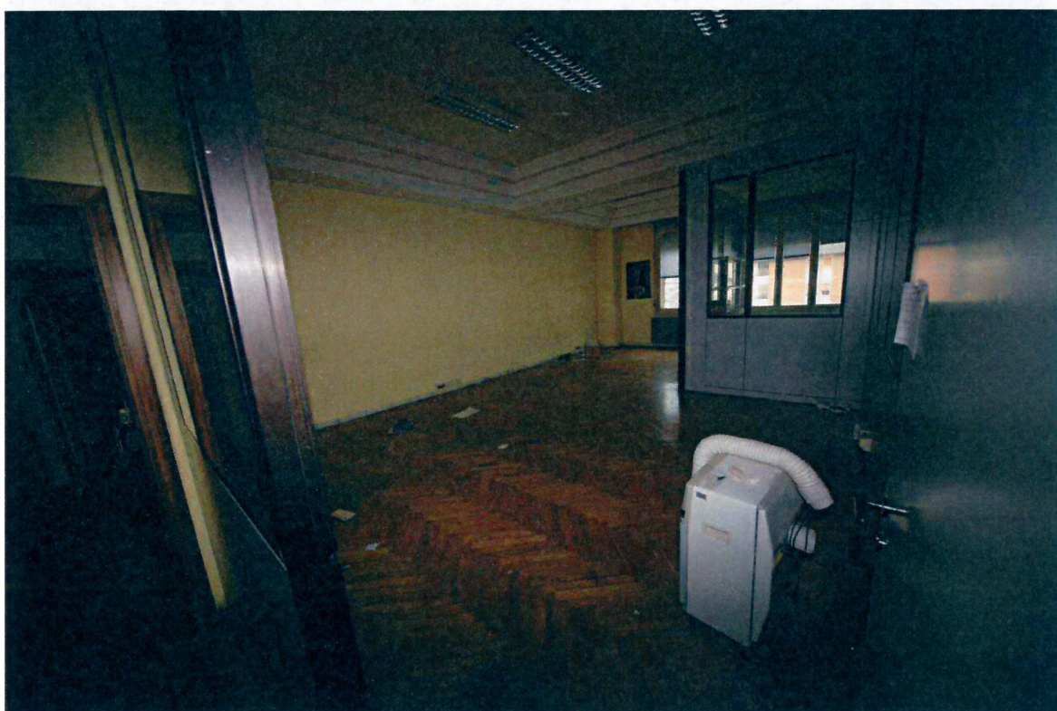
Vista locali con controsoffitto a "scaletta" del secondo piano.
