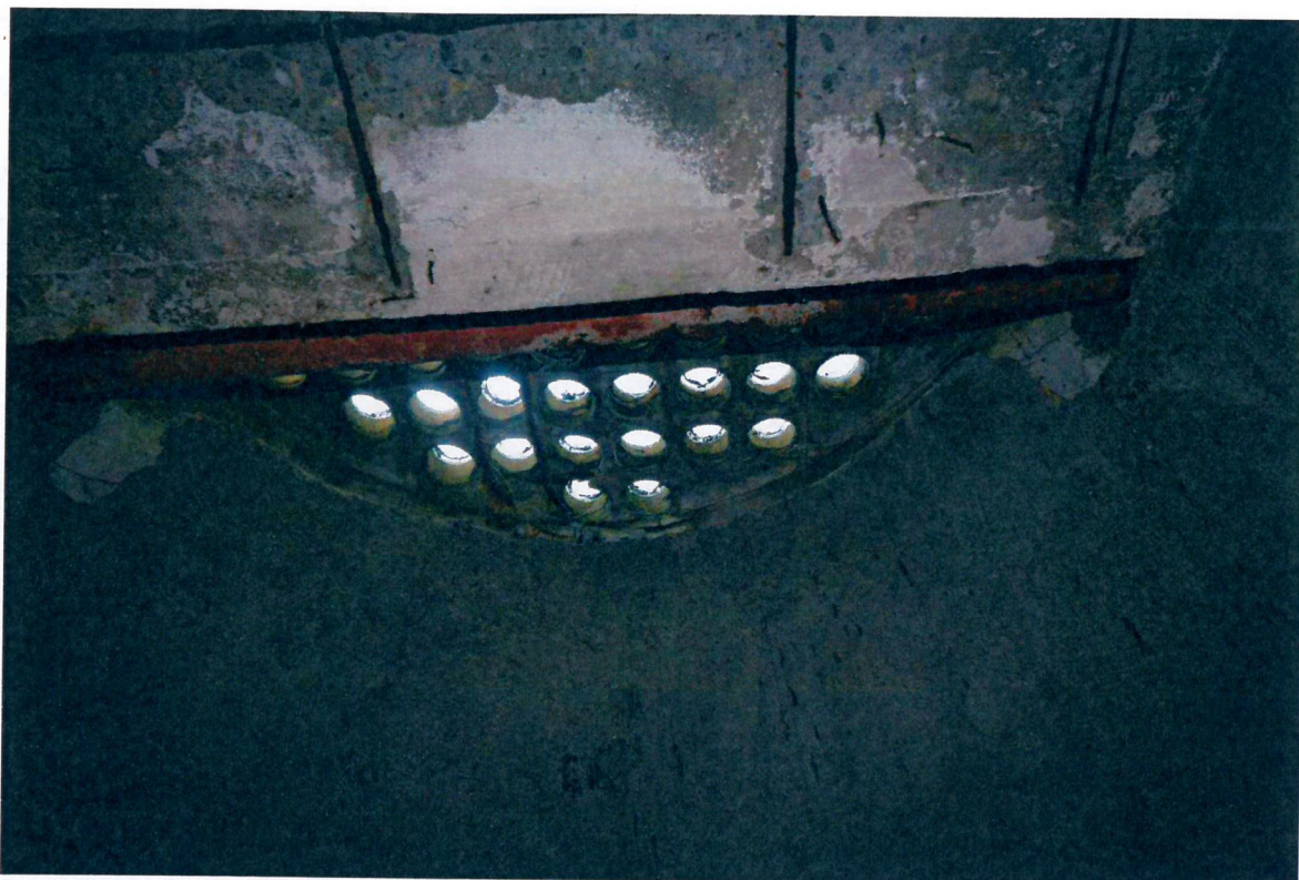
Particolare della bocca di lupo del primo piano interrato.
