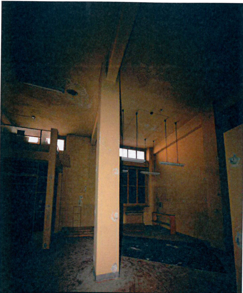
Vista locale di deposito dell'attività commerciale "ex Canonico."
