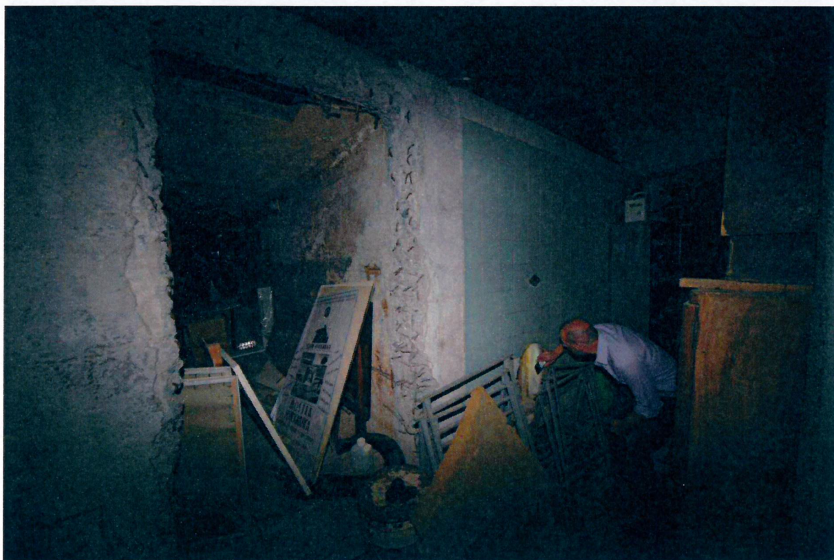
Vista cisterna primo piano interrato.
