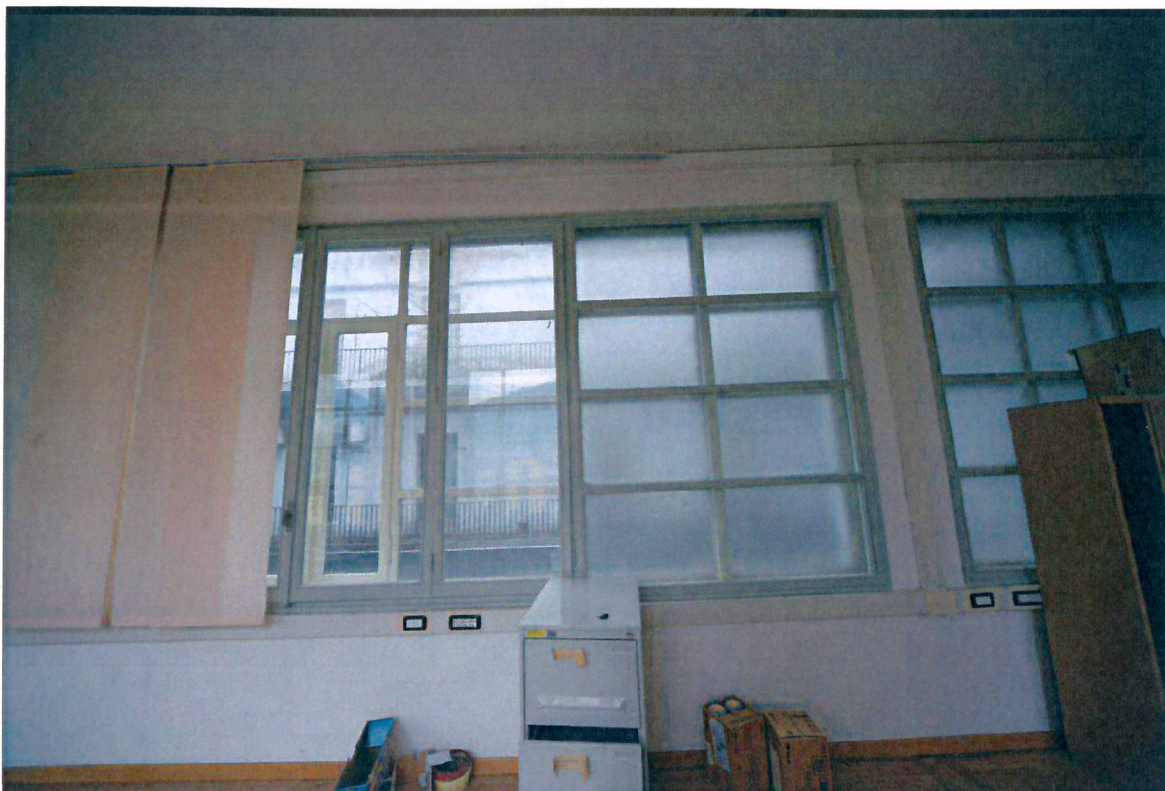
Vista interna dei serramenti del lato nord del secondo piano dell'edificio.
