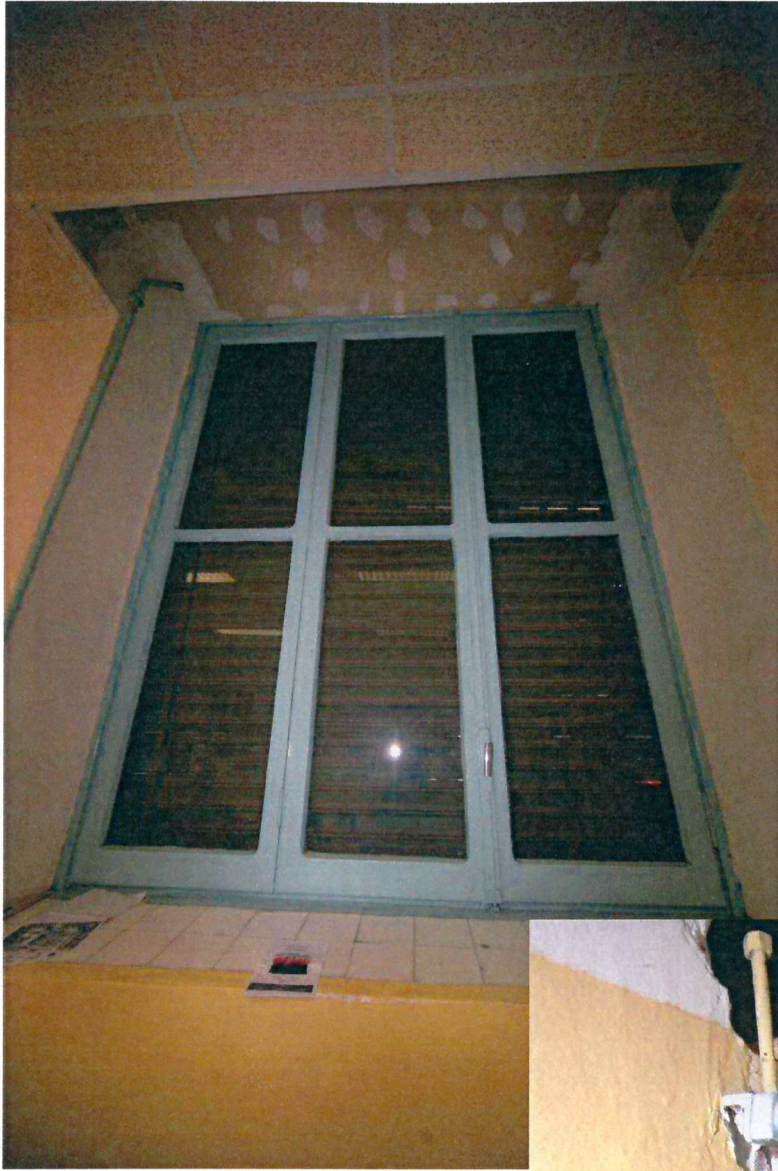
Particolare della finestra e del meccanismo di azionamento delle tapparelle esterne.
