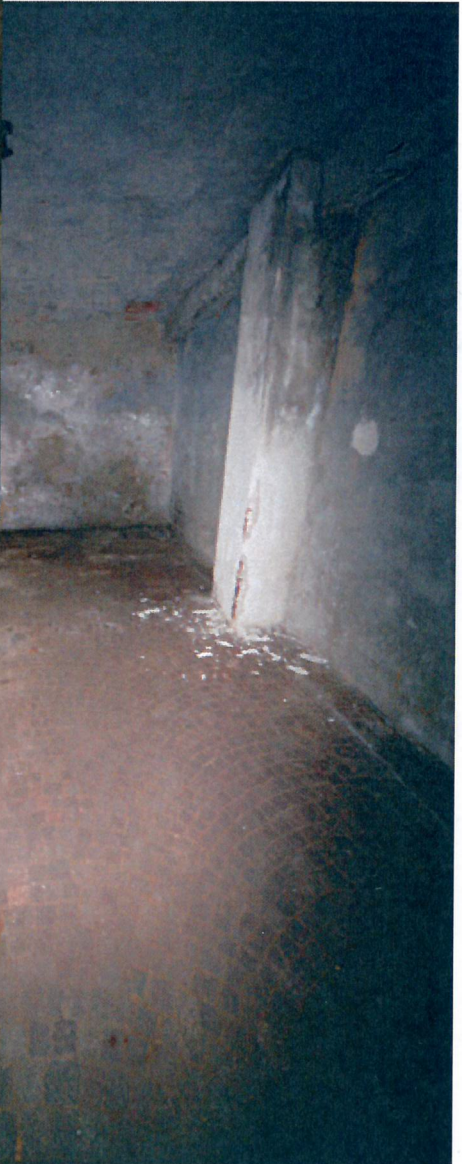
Scala di accesso al secondo piano interrato denominato "Infernetto" e della pavimentazione in porfido.
