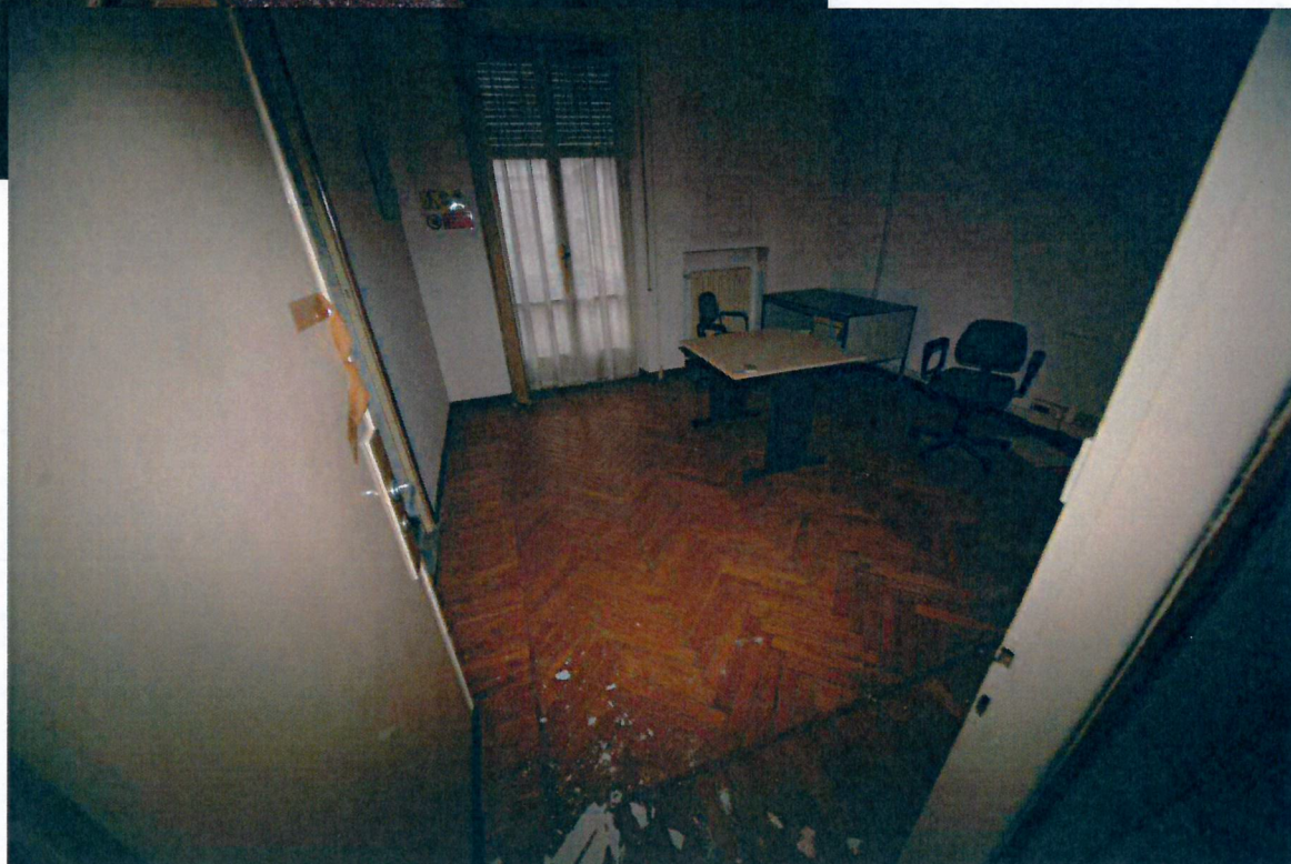
Vista interna di uno dei locali del terzo piano.
