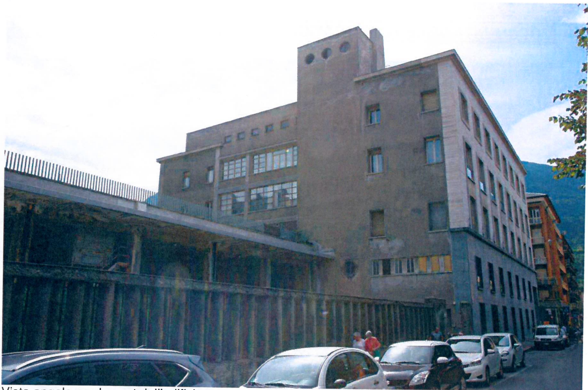
Vista angolo nord-ovest dell'edificio.
