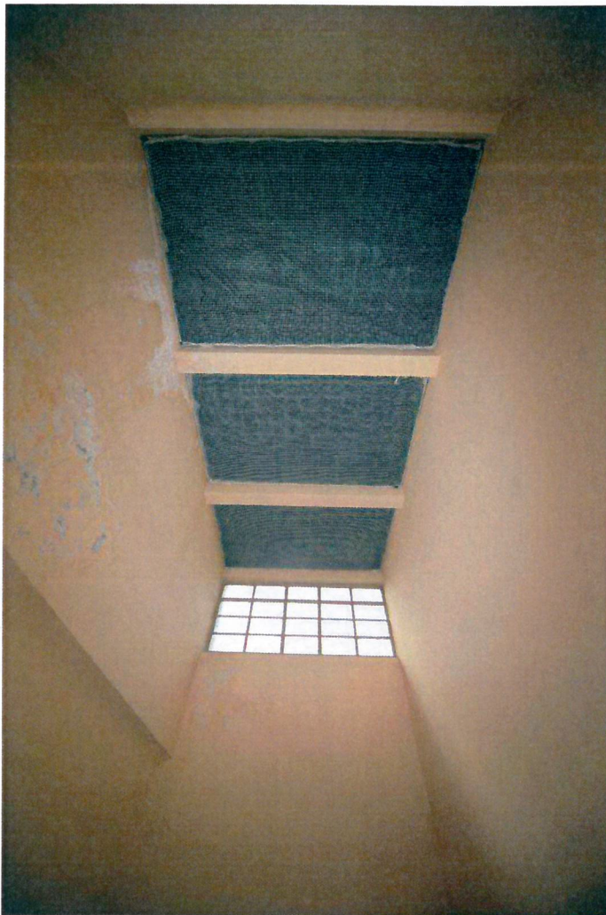
Vista soffitto con copertura e finestratura laterale in vetro-cemento del corpo scala secondario su c.so Battaglione Aosta.
