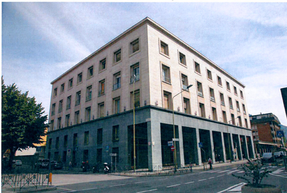
Vista angolo sud-ovest dell'edificio.
