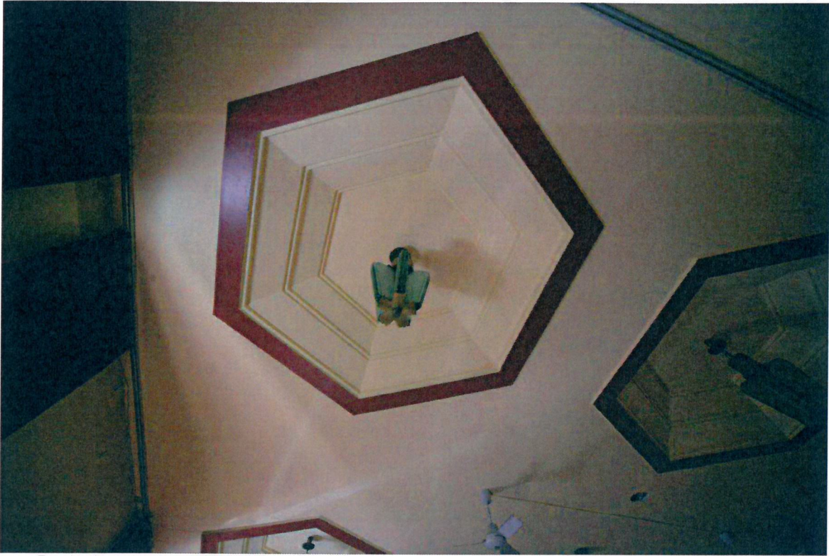
Particolare controsoffitto della sala da ballo piano primo.
