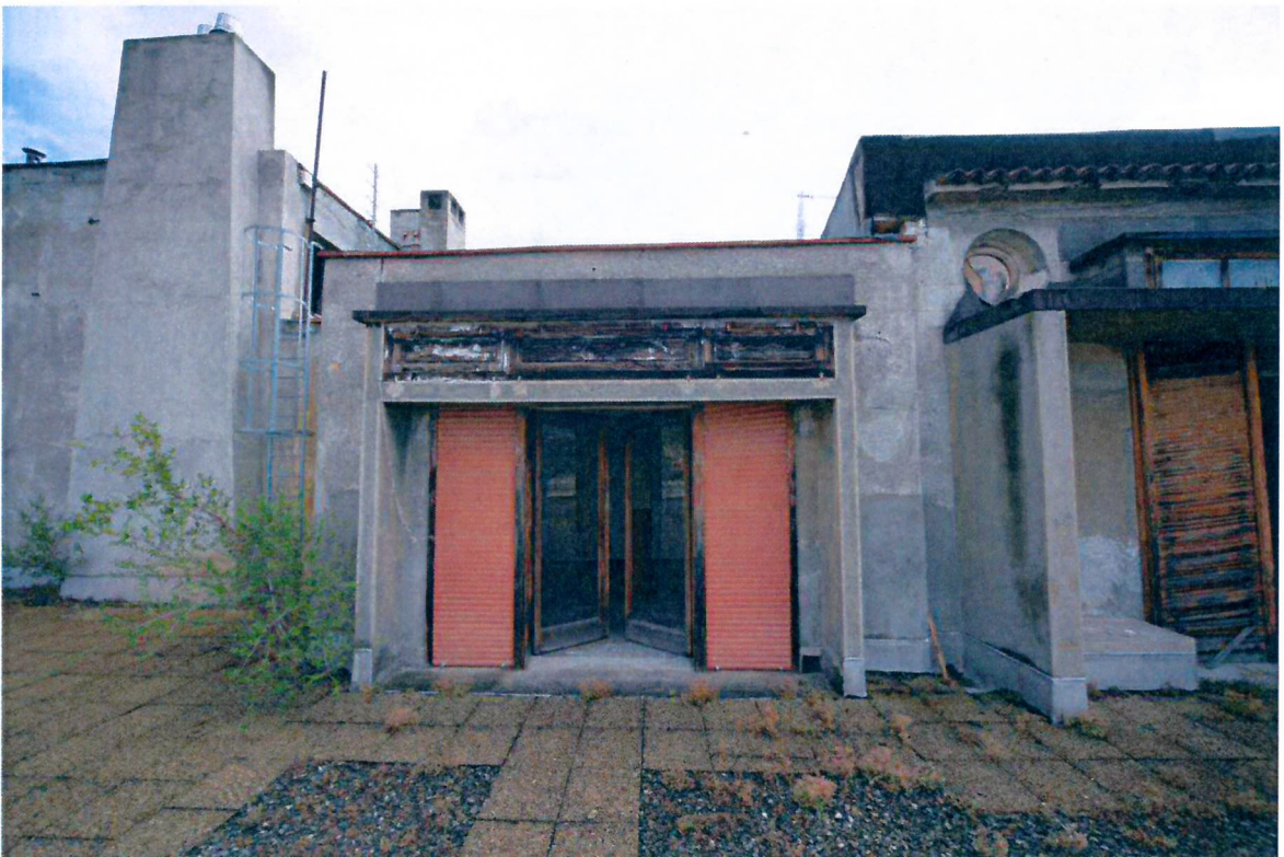
Particolare del lato ovest del quarto piano.
