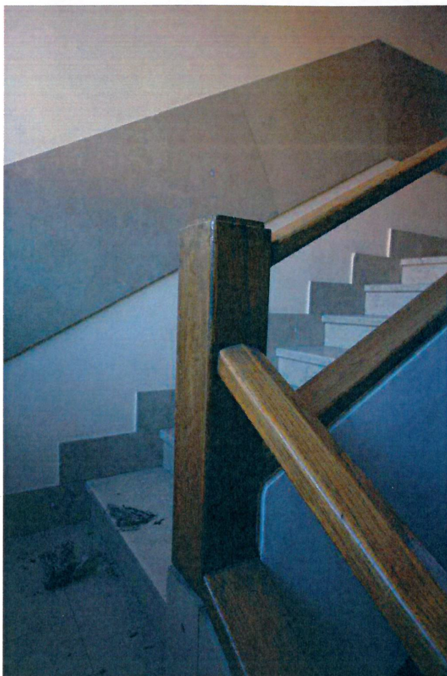
Particolare del mancorrente e della scala su via G. Elter.
