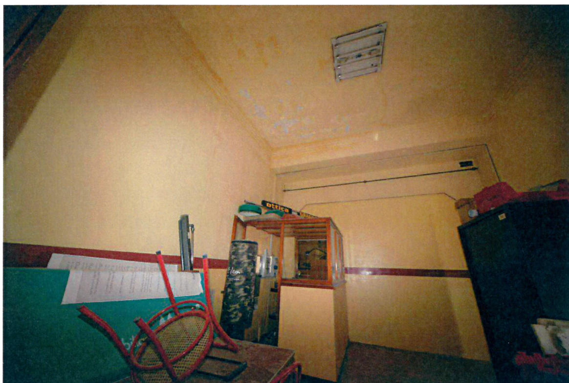
Vista locale di servizio della sala da ballo piano primo.
