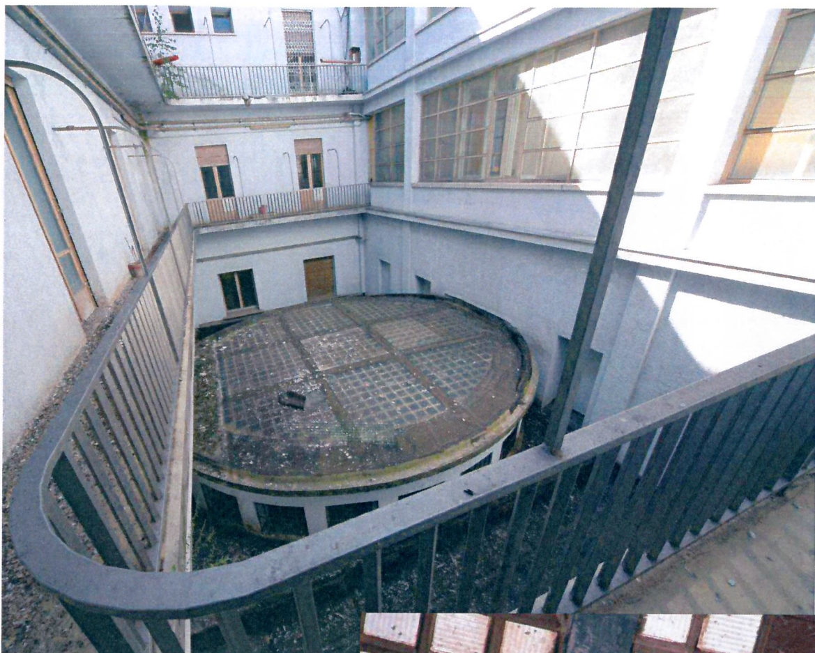
Vista dal primo piano del cavedio interno con lucernario in vetro-cemento che illumina il salone del piano terreno.
