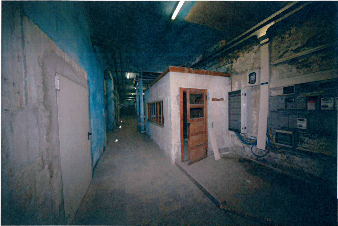
Vista esterna del locale al primo piano interrato adiacente al montacarichi.
