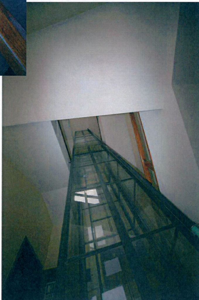
Vista vano ascensore della scala su via G. Elter.
