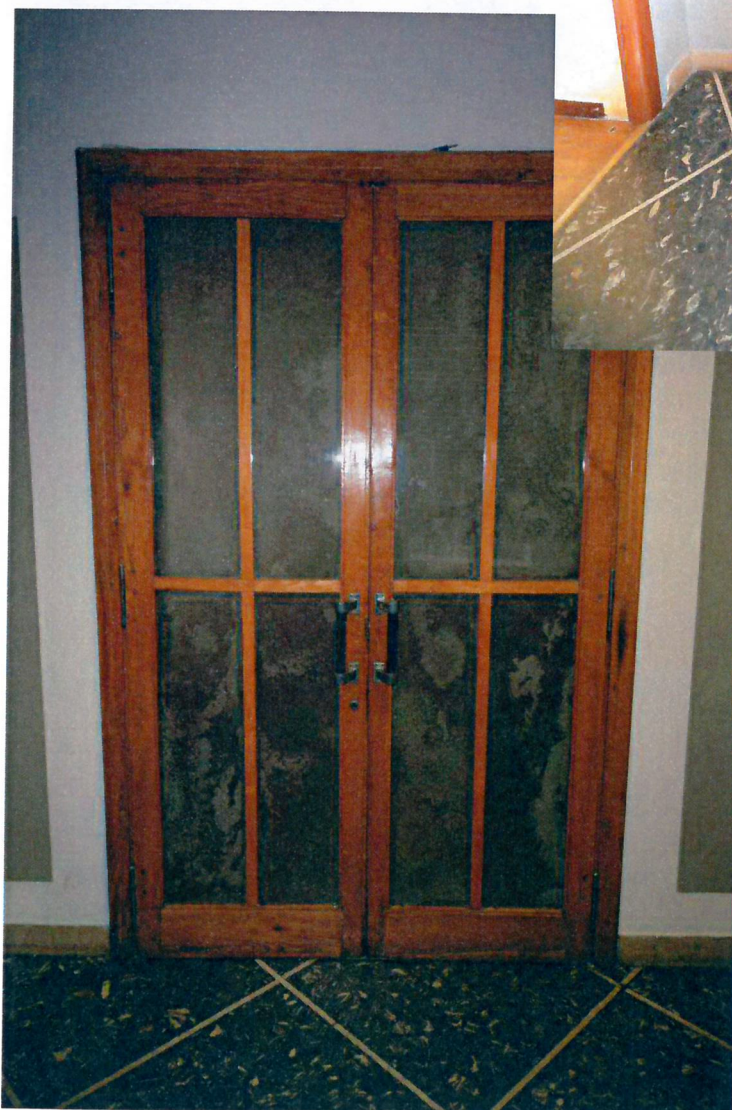
Vista serramento interno piano primo.
