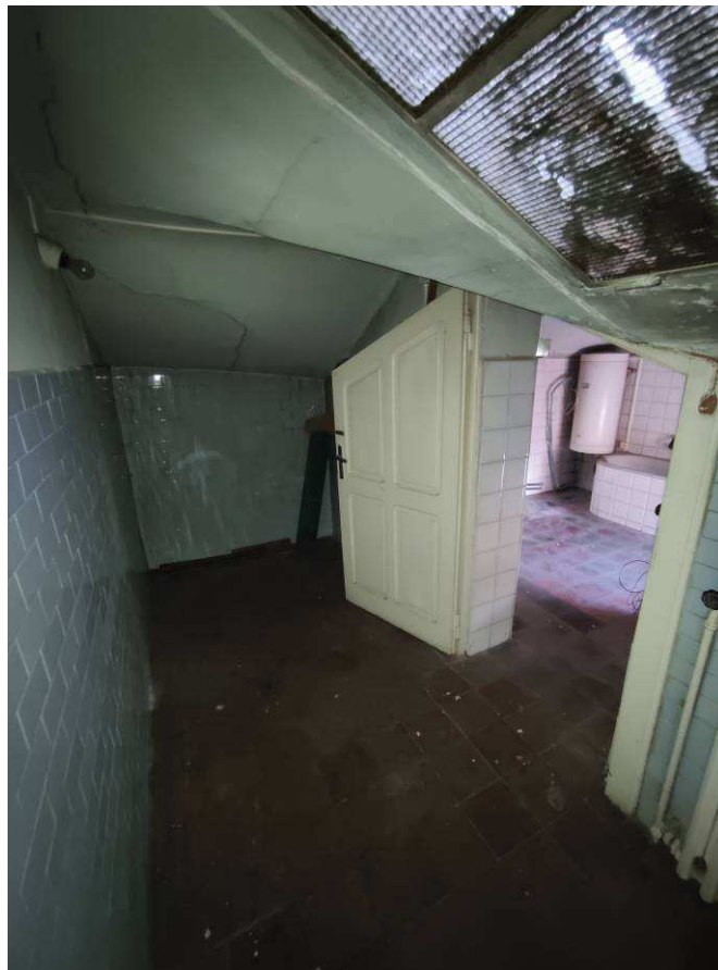
Corridoio di accesso al bagno di uno dei due alloggi del sottotetto.
