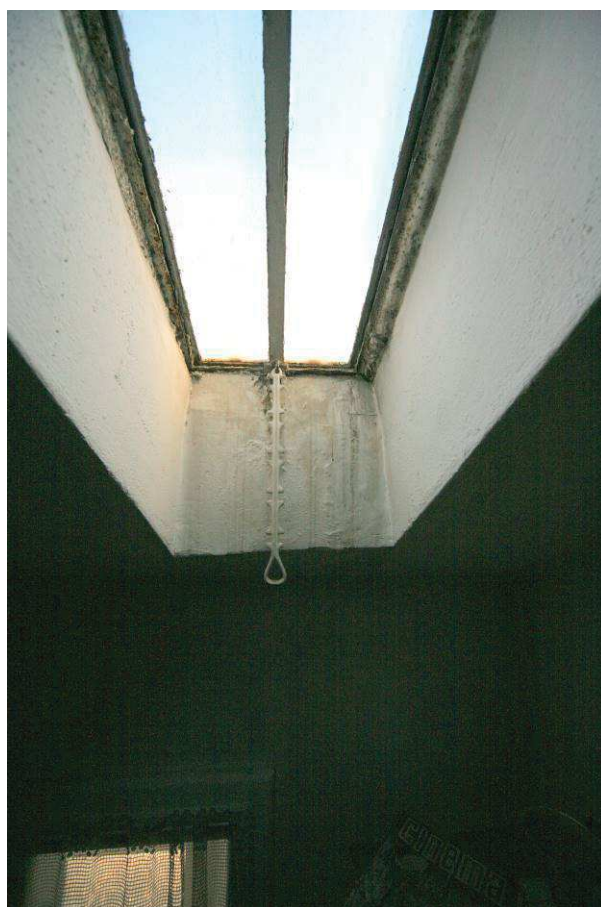
Particolare sistema di apertura del lucernario.
