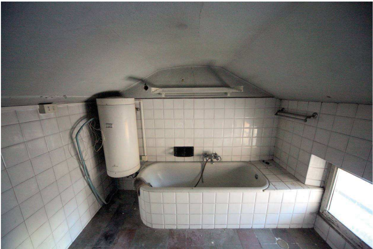
Bagno di uno dei due alloggi del sottotetto.
