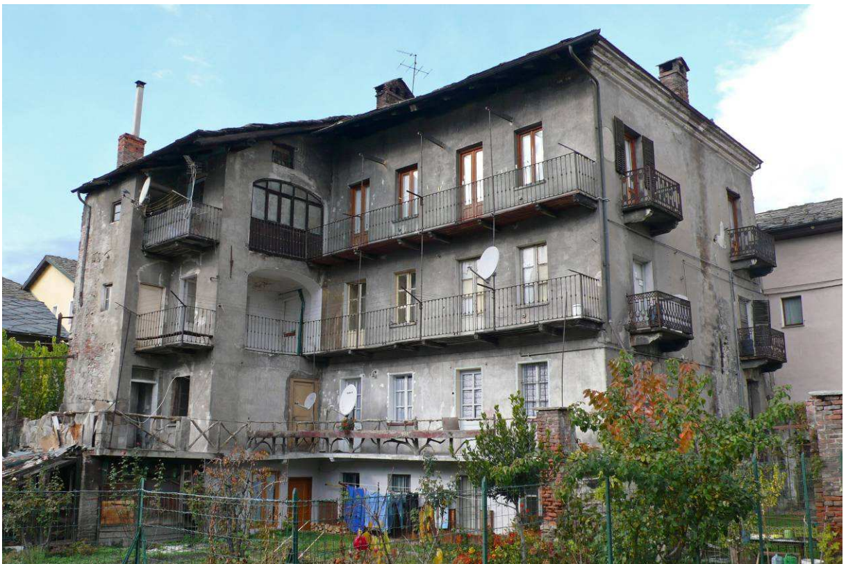
Vista prospetto sud-est.
