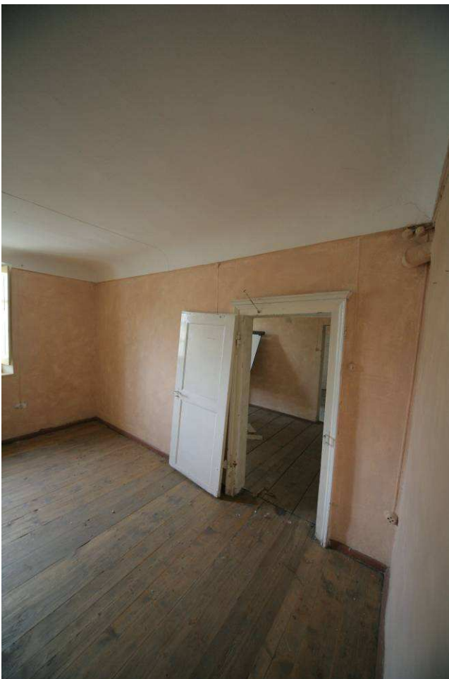
Vista d'insieme della porta di un locale dell'ala est con sistema di chiusura e cornice.
