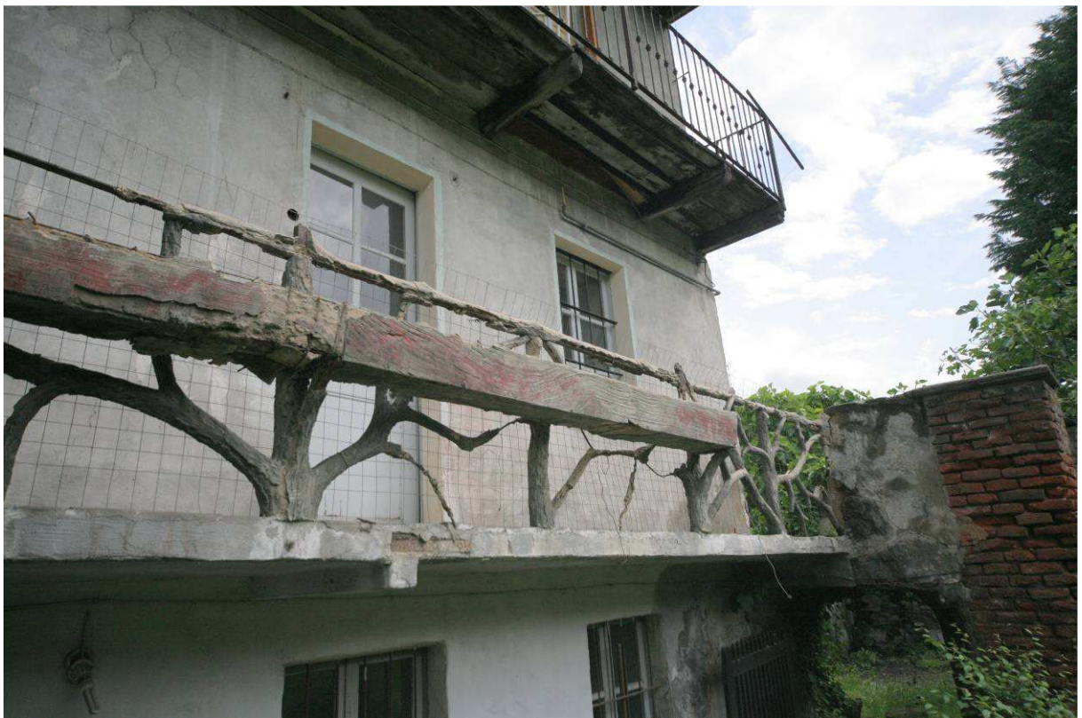
Particolare del parapetto in cemento del balcone al piano primo.
