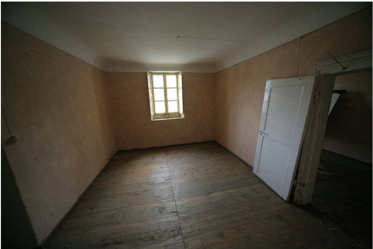
Vista d'insieme di uno dei locali dell'ala est, con la pavimentazione in legno, la finestra con ante interne e porta con cornice.
