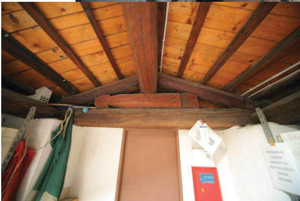
Vista della struttura lignea del tetto del palazzo.
