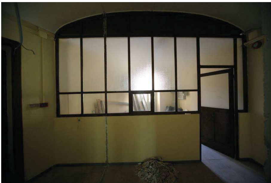
Particolare di un serramento interno.
