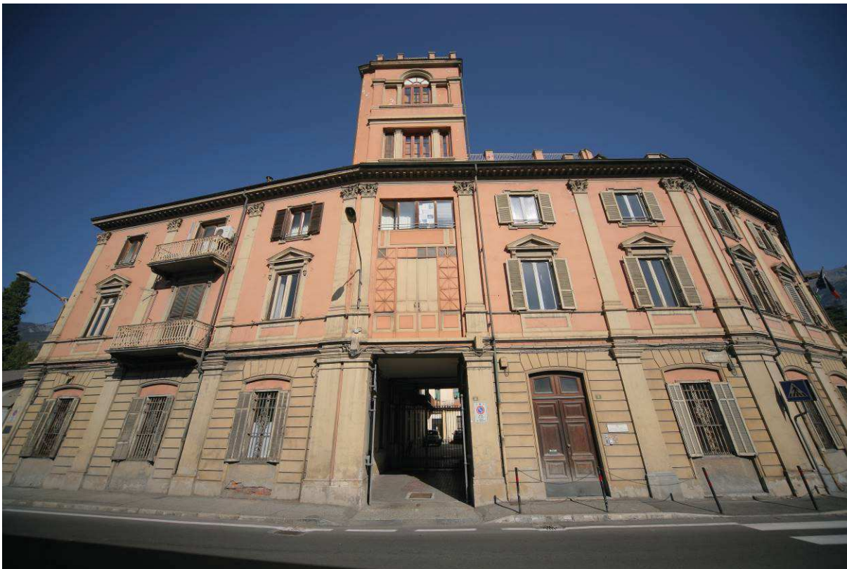
Vista lato sud dell'edificio.
