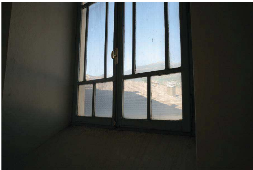
Particolare del serramento della scala di accesso.
