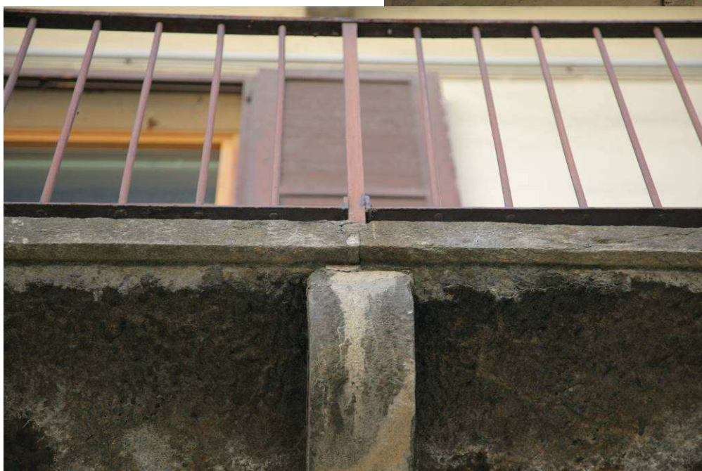
Particolare del ballatoio e della mensola di sostegno in pietra.
