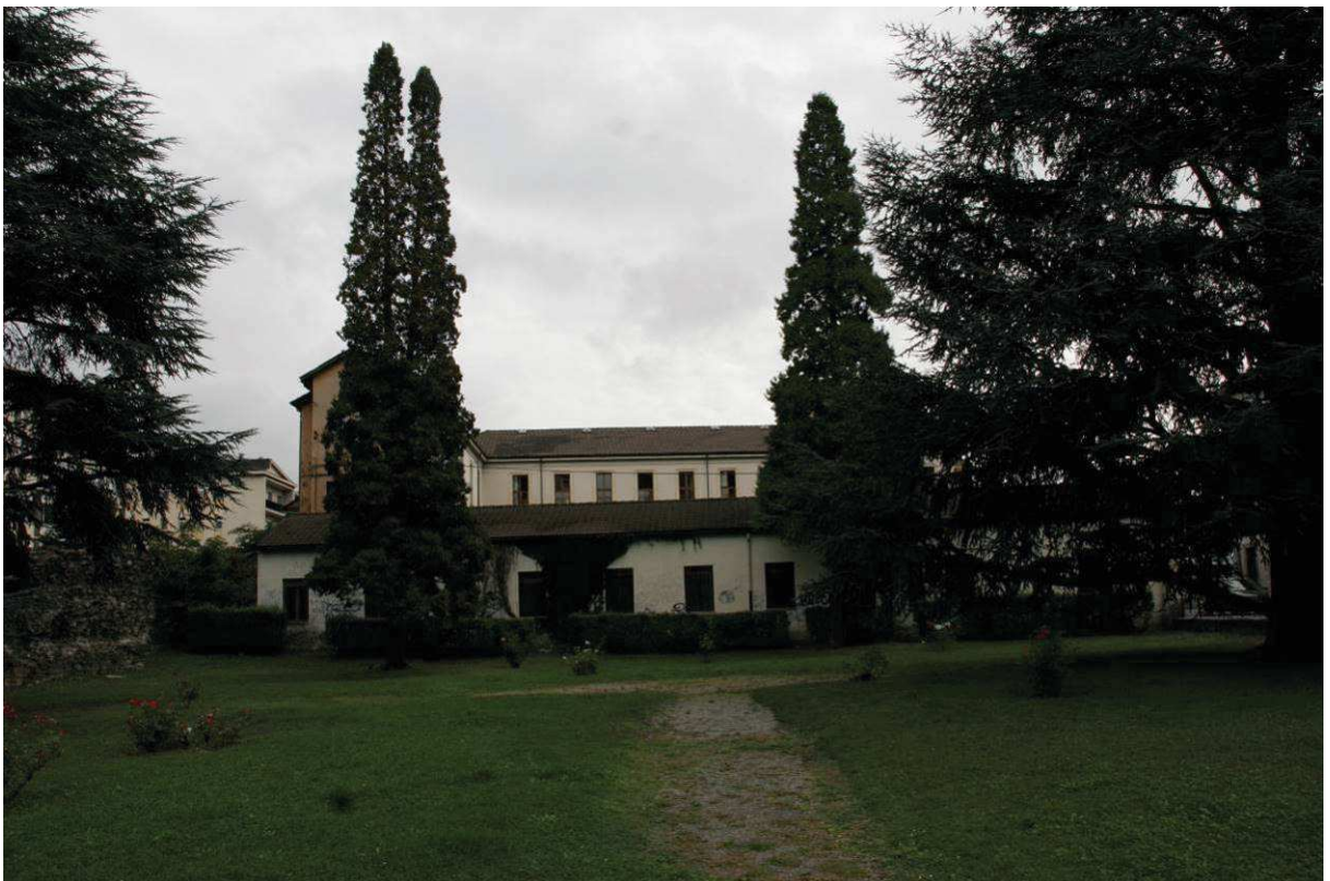
Vista lato ovest dell'edificio.
