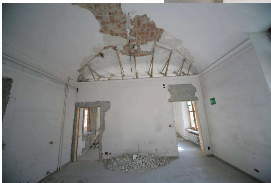
Vista delle diverse tipologie di solai voltati presenti in alcuni ambienti del Palazzo.
