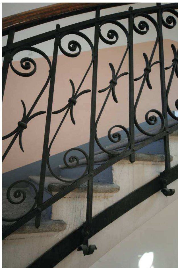
Particolare del parapetto in ferro della scala secondaria.
