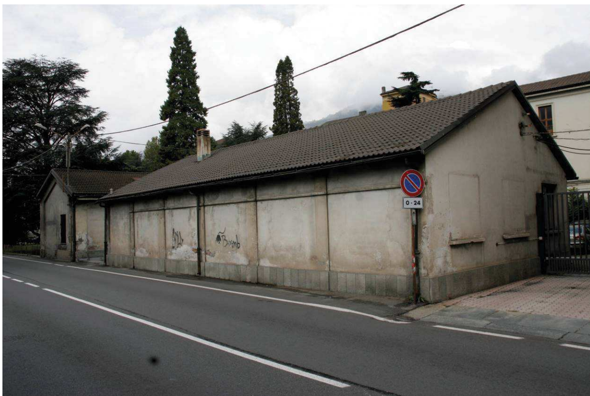
Vista lato sud dell'edificio basso.
