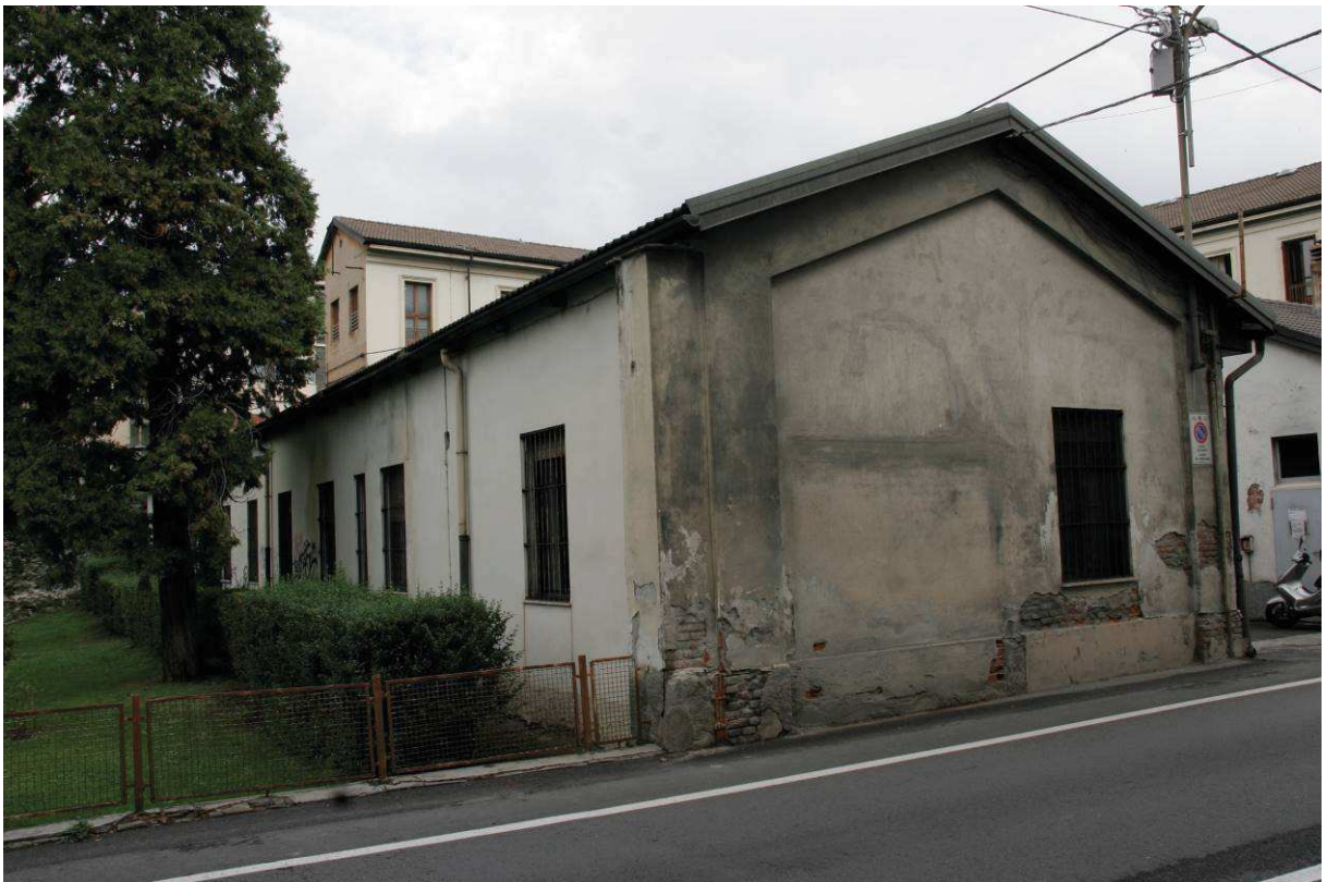
Vista lato sud-ovest dell'edificio.
