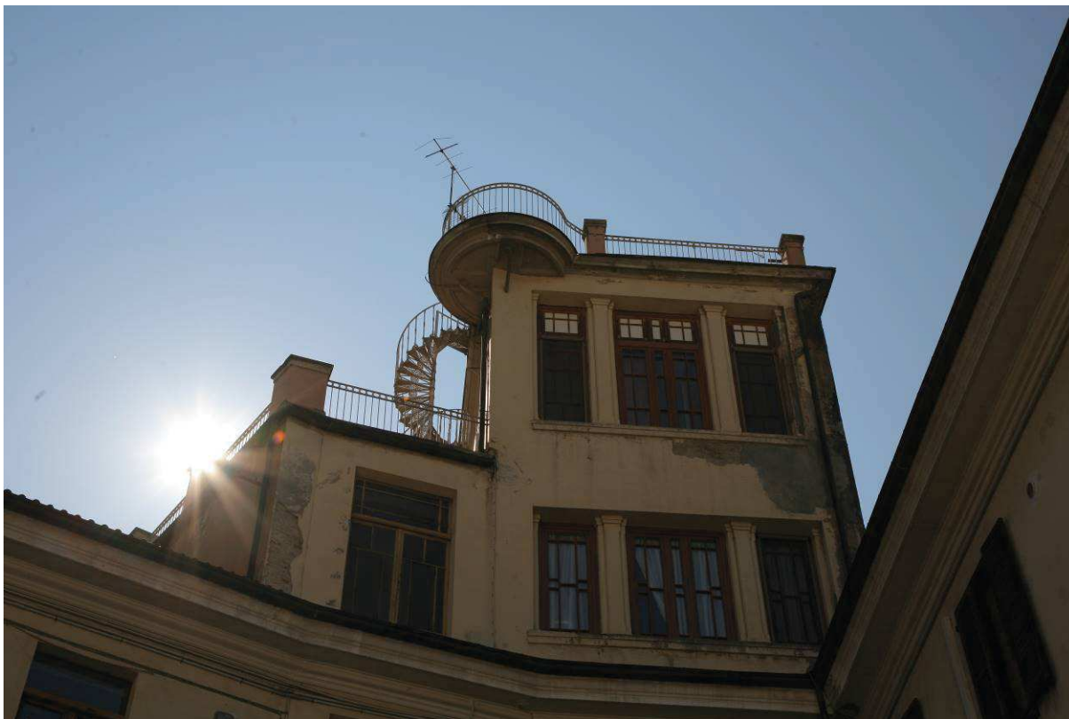
Vista della torretta del lato sud dall'interno del cortile.
