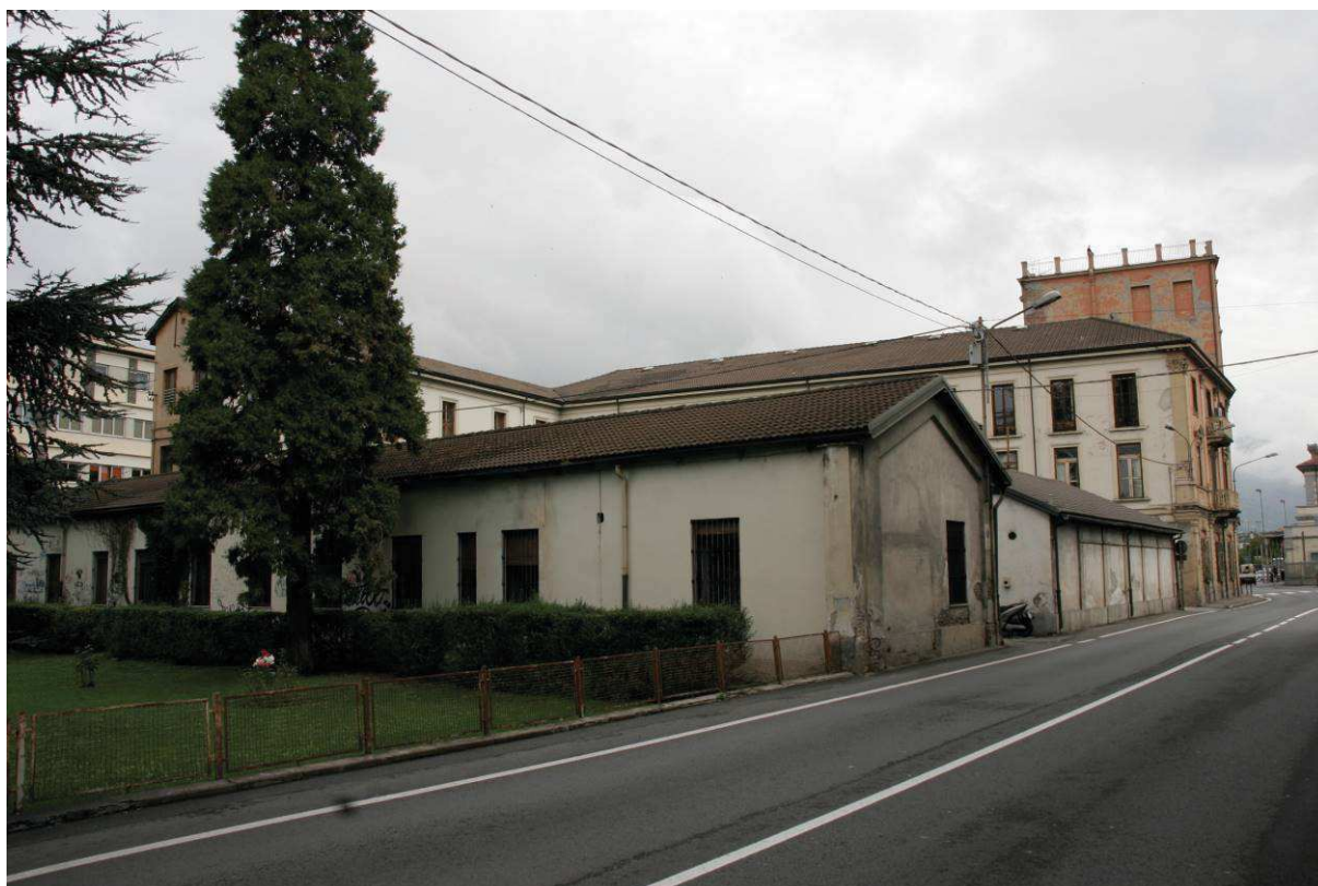
Vista lato sud-ovest dell'edificio.
