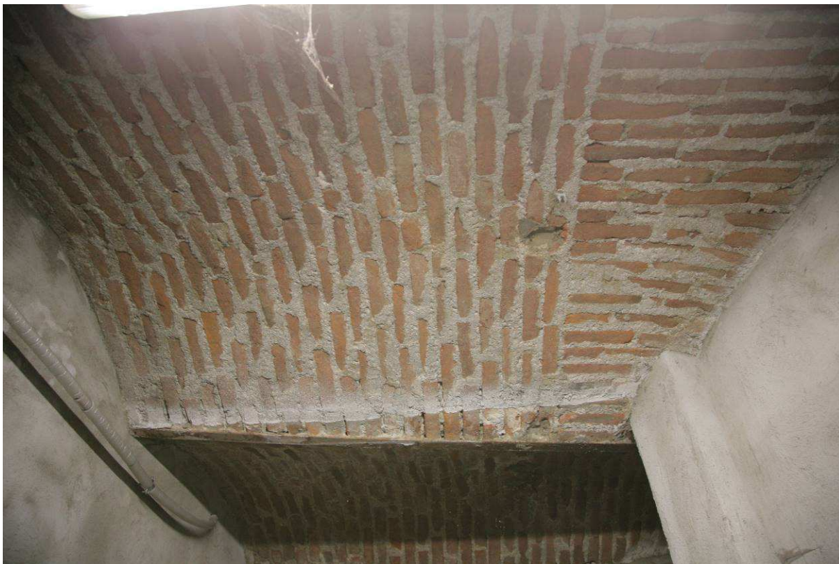
Particolare delle volte del piano interrato.
