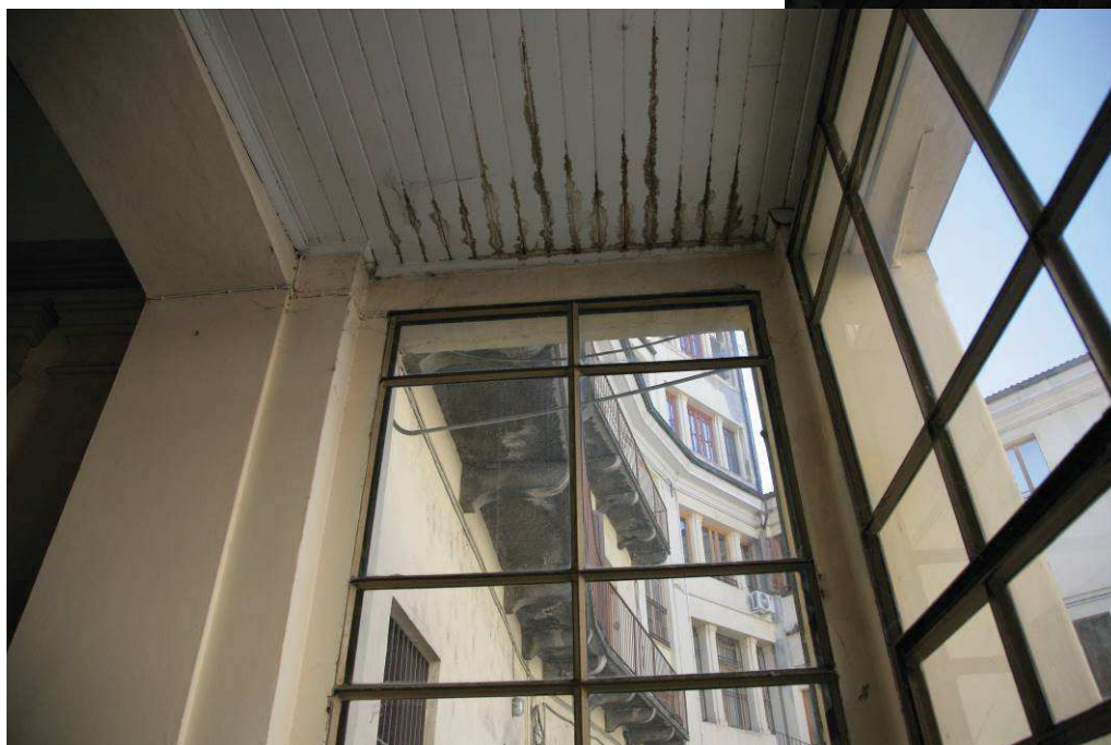
Particolare della vetrata dell'ingresso nella corte interna.
