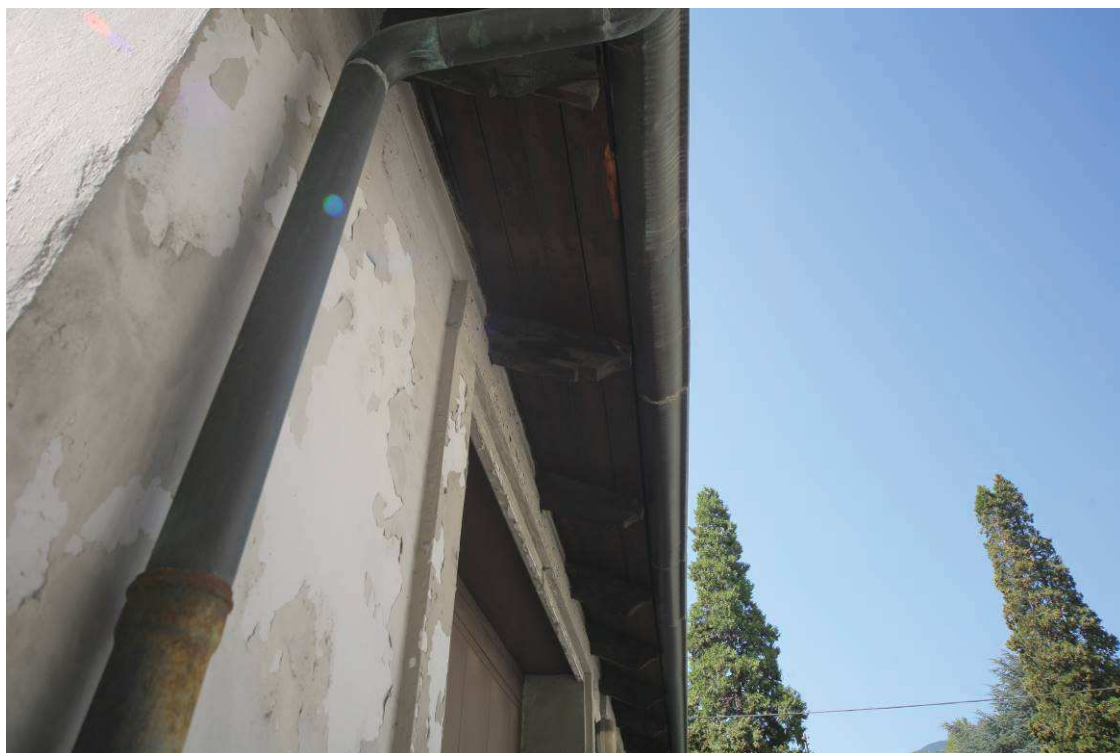
Particolare della copertura dell'edificio basso posto a sud.
