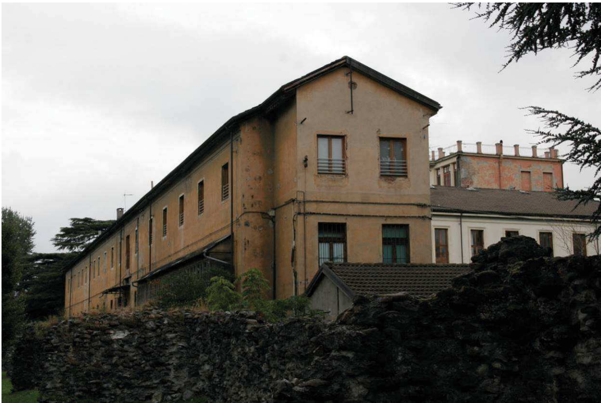
Vista lato nord-ovest dell'edificio.
