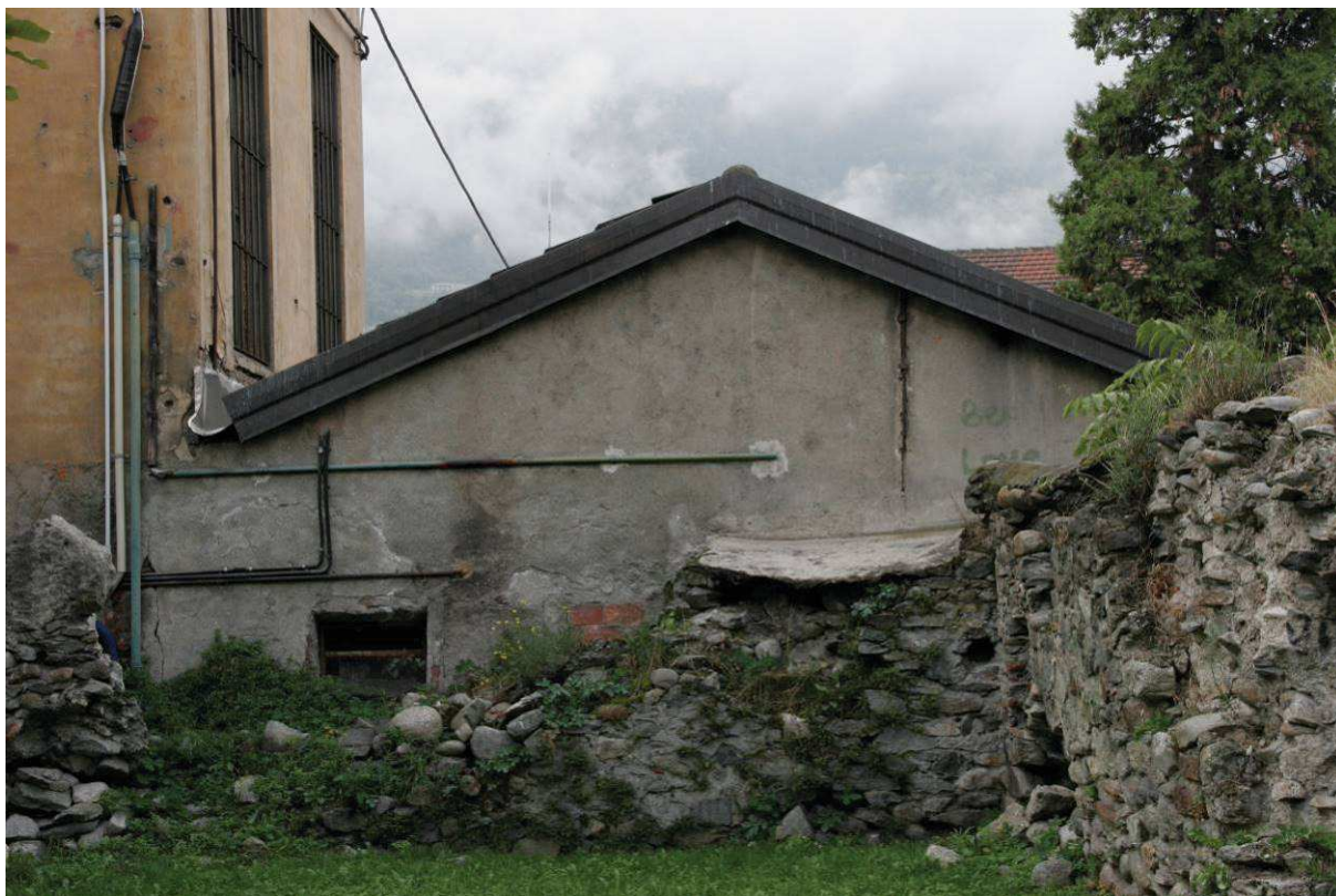
Vista lato nord dell'edificio basso.
